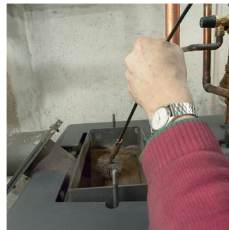
3. Den viska som medföljer vid leverans av Ariterms pelletspannor trycks ner genom rökgaskanalerna så att den sot som fastnat på sidorna faller ned i askbehållarens inre fack.
