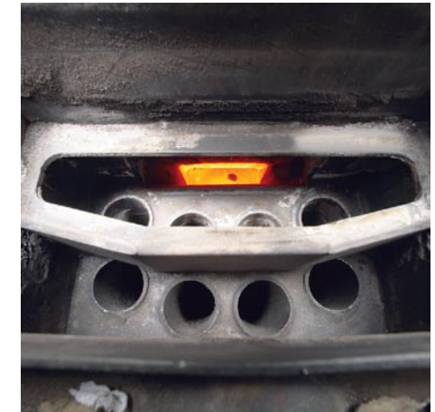
2. Rengöring av rökgaskanalerna. Rökgaskanalerna behöver rengöras (sotas) några gånger per år. De nås genom att sotluckan på pannans ovansida öppnas.
